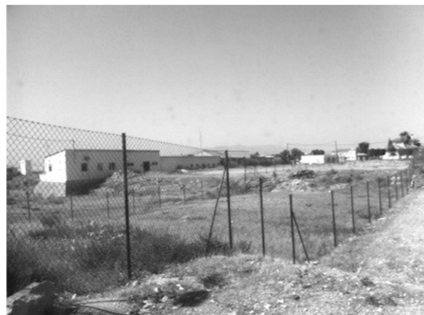
スペインのパロマレス村にある、プルトニウムで汚染された土地を住居や学校と隔てる粗末な塀
