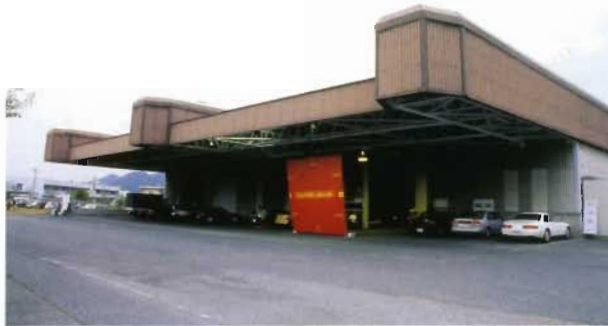
サントリー株式会社 宮島工場内倉庫外観
