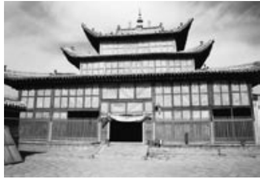
図1 ゴマル寺の三層屋根を持つ弥勒殿
